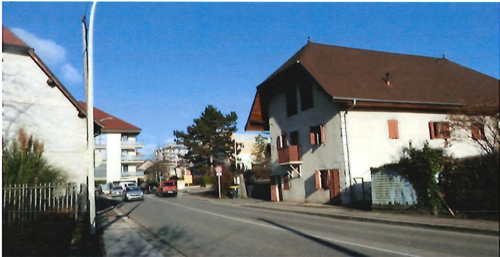
Abords immédiats du MH – Prise de vue UDAP
