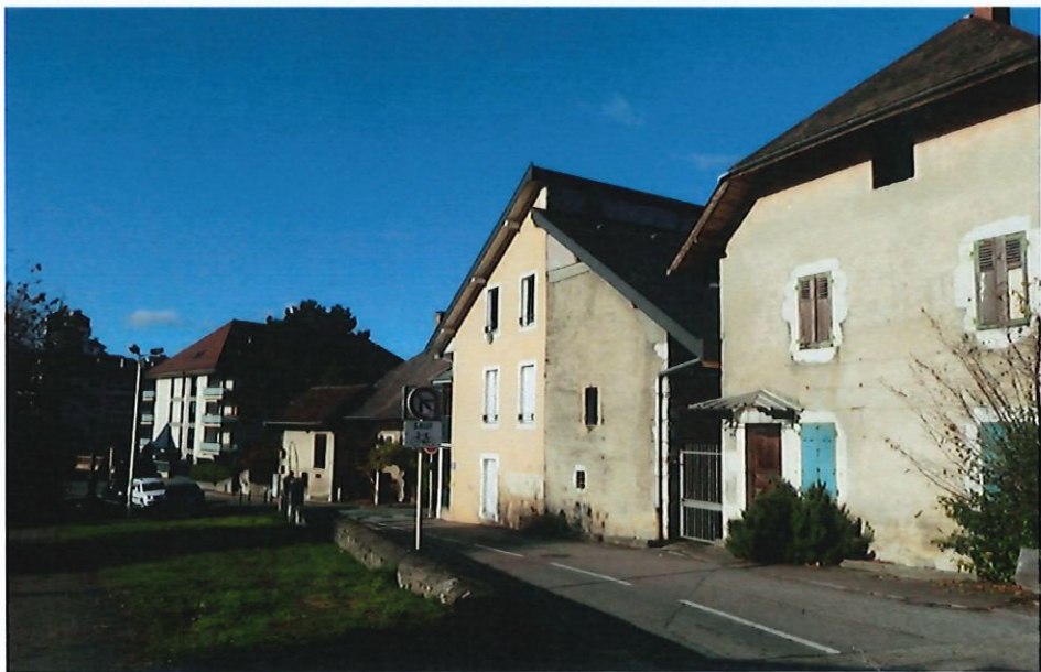
Anciens bâtis agricoles – Prise de vue UDAP
